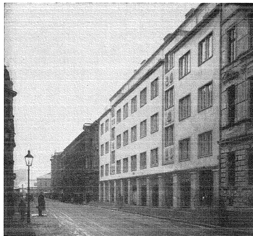
Nová-budova na Palisádoch po prestavbe.
