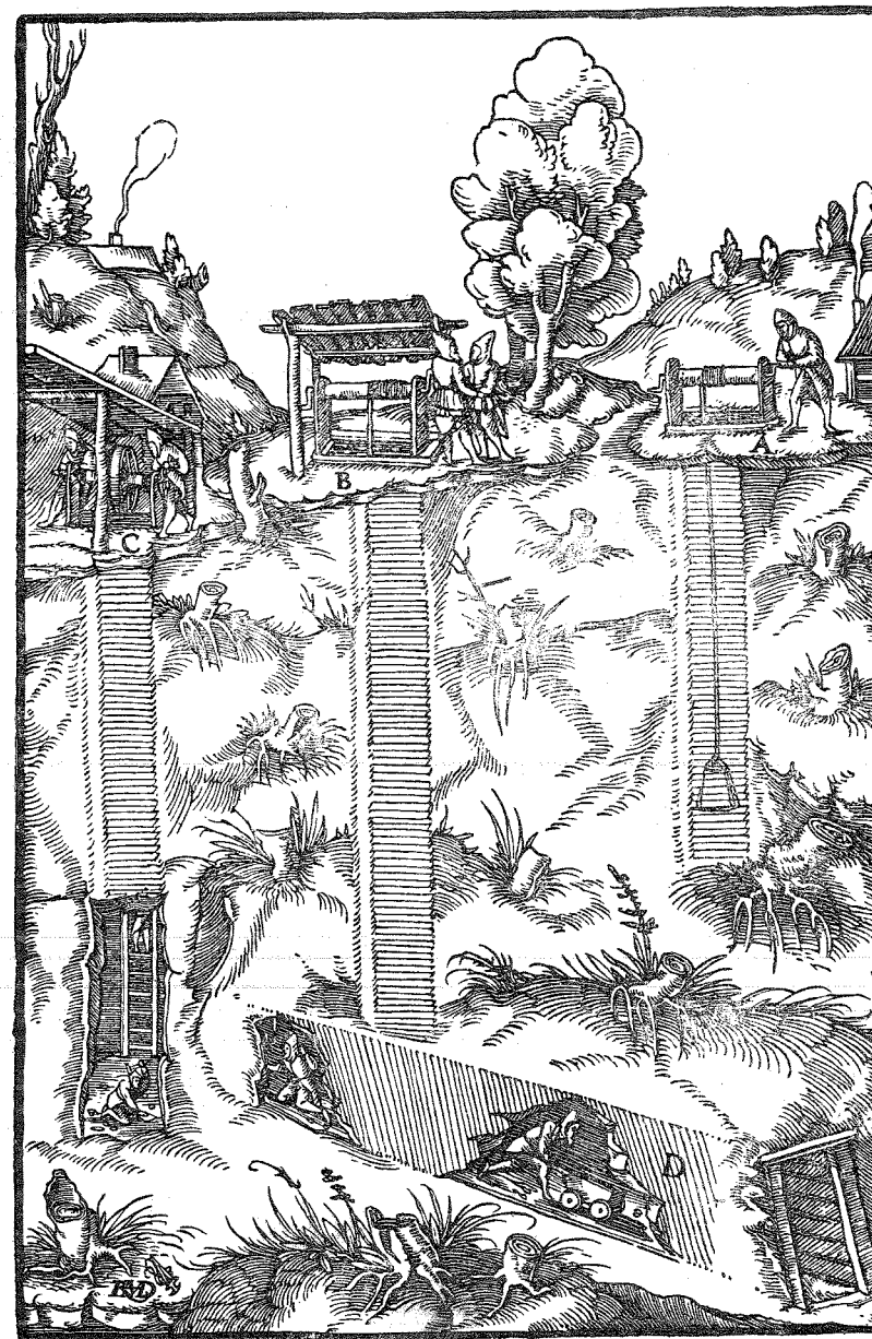
Středověké dolování na železnou rudu.
