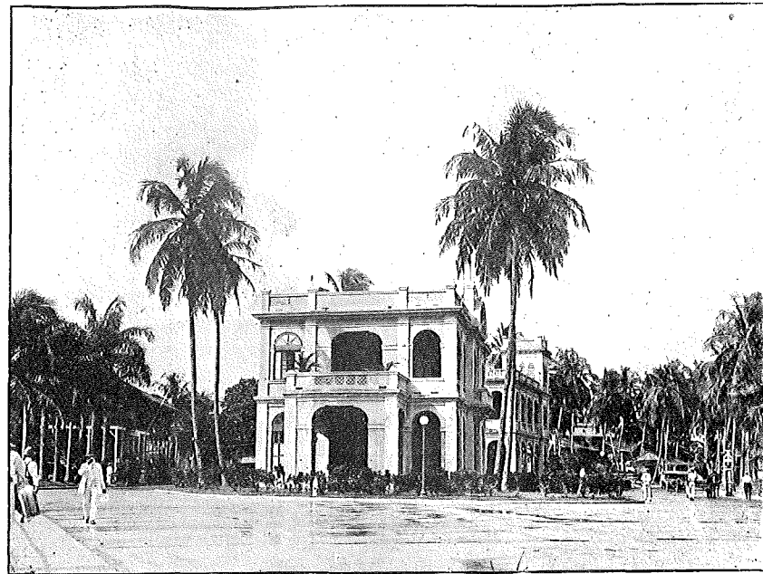
Budova správy průplavu Panamského.
