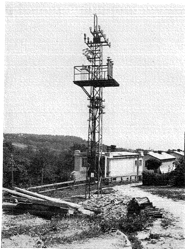
22.000 Volt Transformatorenstation auf der KOLYBA des städt. Elektrizitätswerkes Bratislava.
