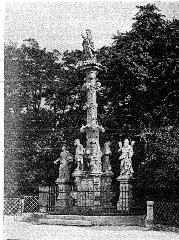
Josefský stĺp. Postavený mestom po zemetrasení r. 1764. (Opraven r. 1830).
