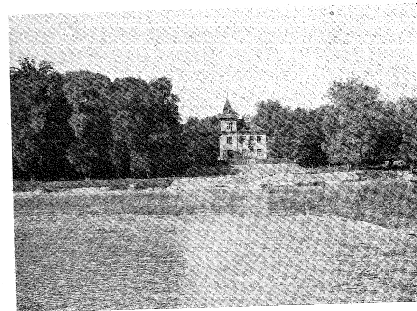
Pumpstation auf der Käsmacher-Insel.
