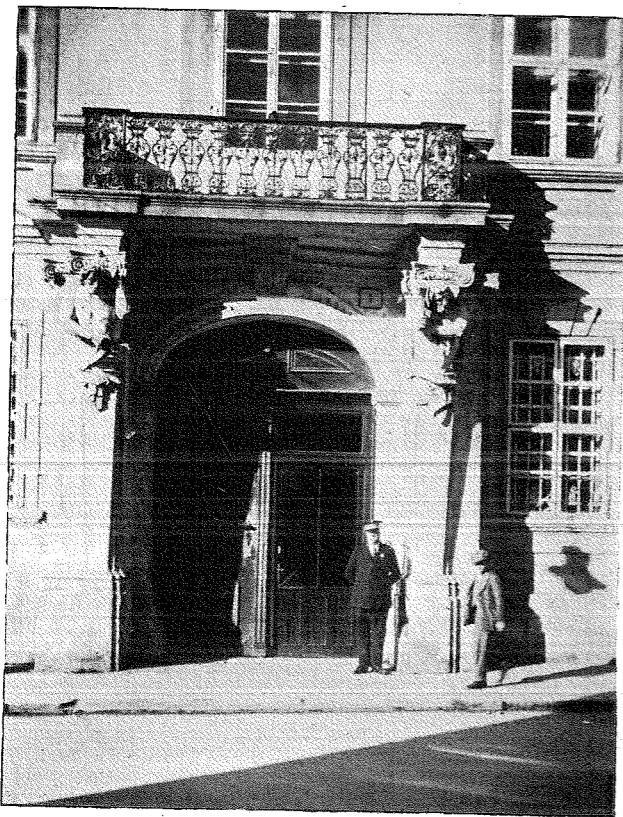
Portál býv. budovy uhorskej kr. komory r. 1753 Giov. Bapt. Martinelliho postavený.
