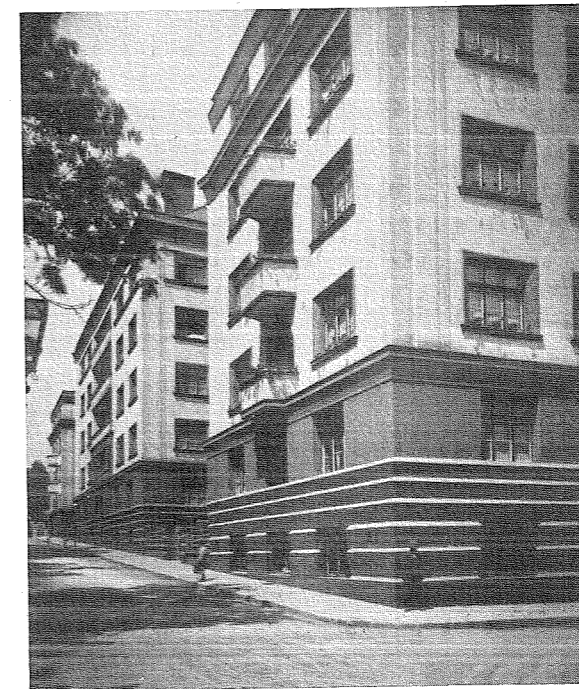
Obytné domy stavebného družstva Tělocvičná ulice.
