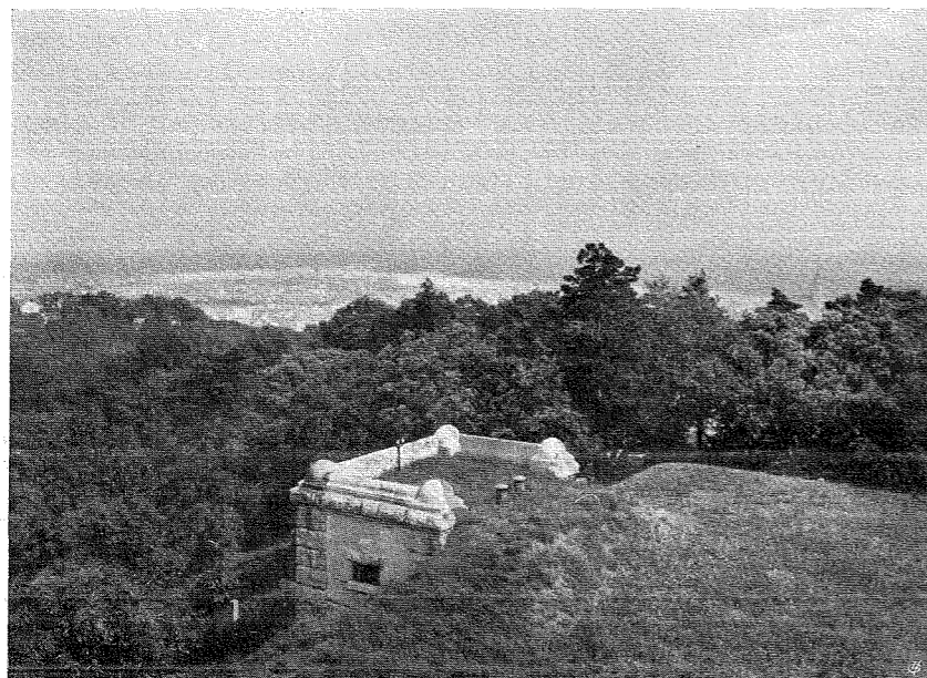
Reservoir auf der Murmannshöhe.
