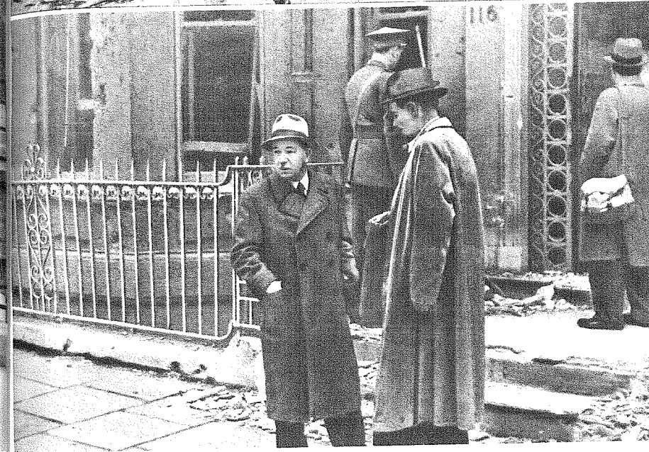
Sídlo čs. Národního výboru v Londýně v č. 114—116 Park Street zničené německou bombou.
