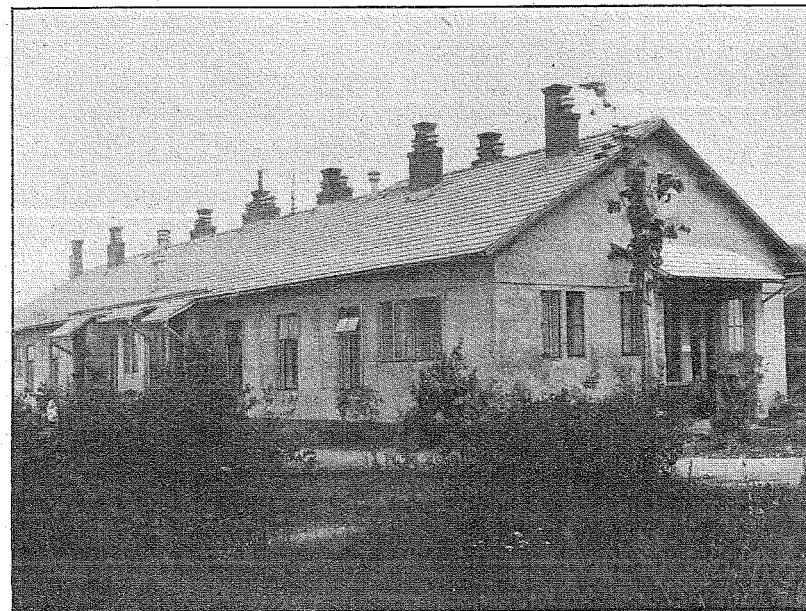
Ruské gymnasium v Moravské Třebové. Nemocnice.
