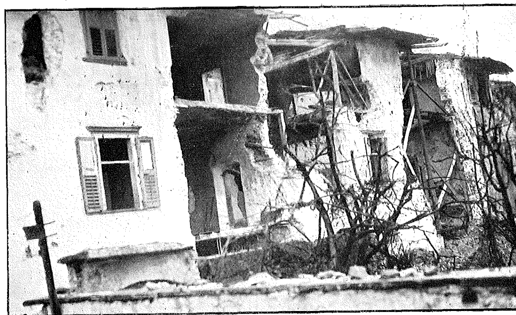
Zříceniny statku ve Val Lagarina.
