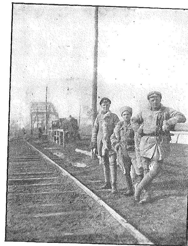
V Kyjevě, stráž před mostem.
