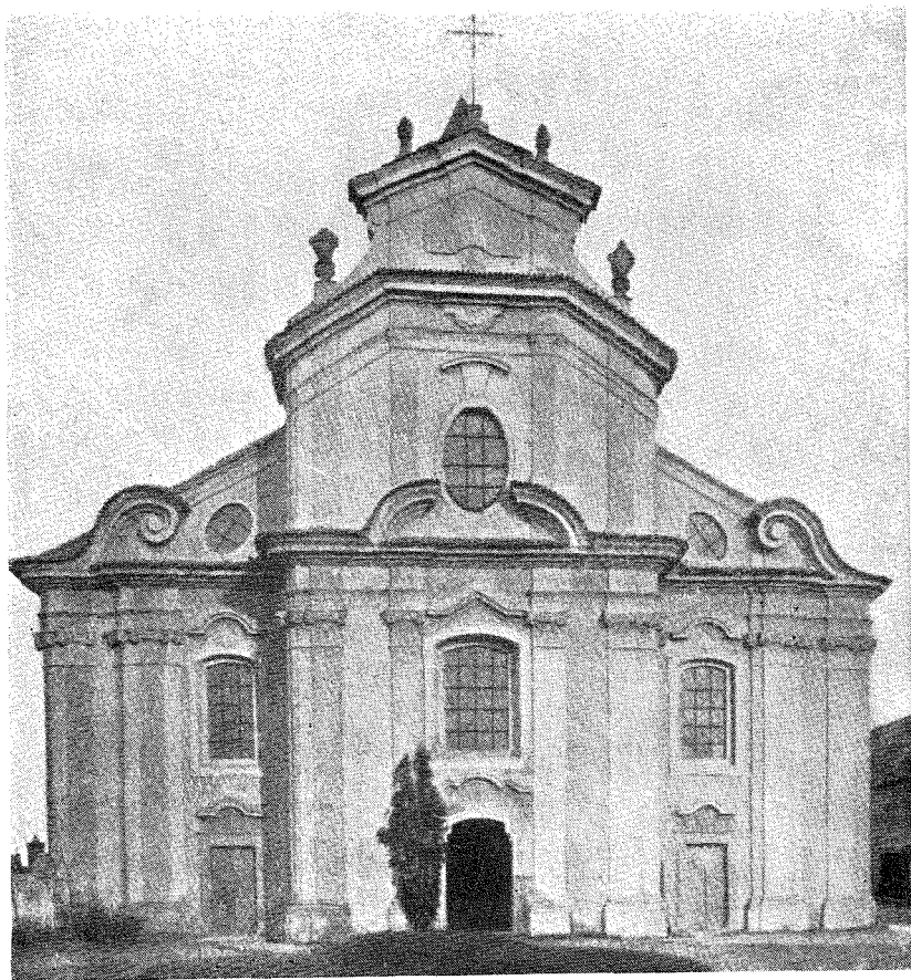
↓ Bývalé barokní průčelí.
