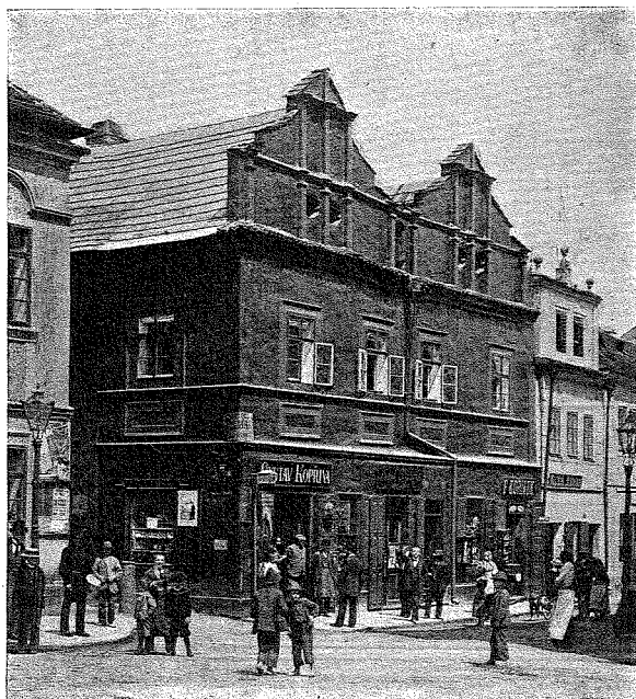
46. DŮM ČP. 62. V DOLNÍ ULICI.
