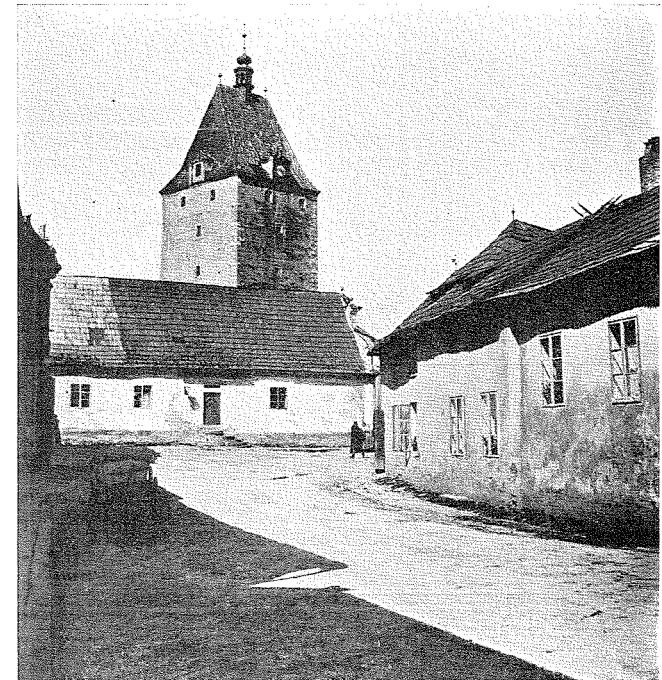
17. POHLED NA DOLNÍ BRÁNU Z KAMENNÉHO MOSTU.
